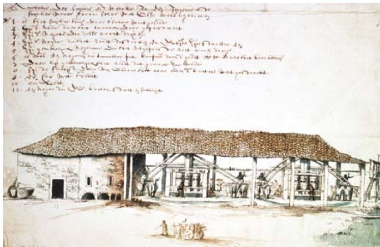
Engenho de duas rodas movido por bois. Desenho de Frans Post. (Haarlem, Holanda, 1612 – 1680). Coleção Stichting Atlas van Stolk, Roterdã. In: LAGO, Pedro e Bia Corrêa do. Frans Post (1612 – 1680): obra completa . Rio de Janeiro: Capivara, 2006.
